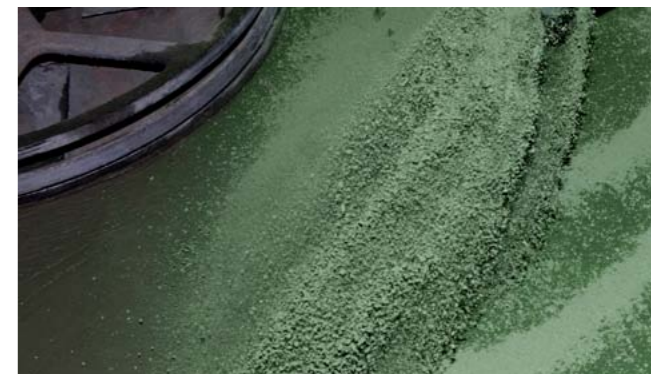
Нанесение Mapetop N AR6 вручную
